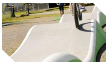
Largeur du circuit augmentée à 1.2 m, pour une conduite sécuritaire tout en évitant les dépassements entre les usagers.
