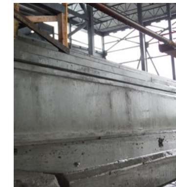
Modification des marches de béton pour s'ajuster aux normes
