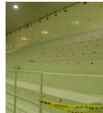
Revêtement peinture et époxy
