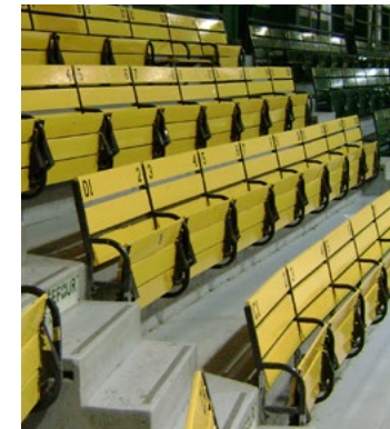
Enlèvement des sièges existants
